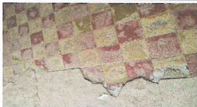
Foto 3: Este piso se encuentra en las aulas que se va a sustituir por piso de cerámica.
