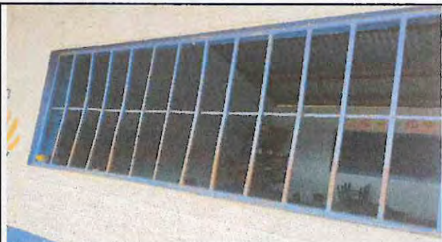
Foto 4: Estos balcones se les dará mantenimiento lijado, soldadura y pintura.
