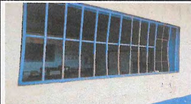
Foto 2: Esta es una de las ventanas que se van a sustituir por ventana de pvc y vidrio.
